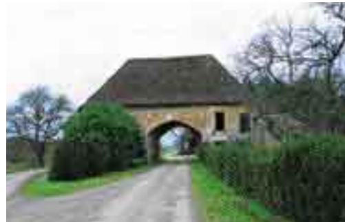
LES ÉCHARLIS (Yonne, Bourgogne). La porterie (xii e -xvii e s.) ; le passage pour les piétons a été bouché, mais celui pour les chariots est toujours utilisé.
