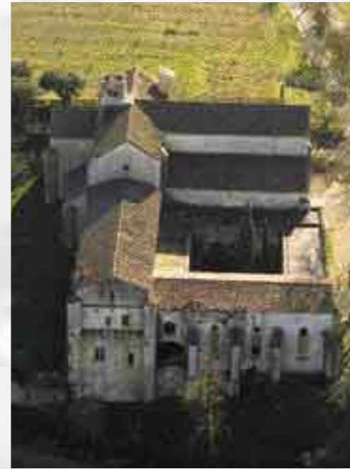
SILVACANE (Bouches-du-Rhône, Provence-Alpes-Côte d'Azur). Vue aérienne depuis le nord.
