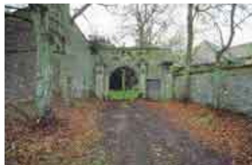
EAU (Eure-et-Loir, Centre). La porterie (xii e s.).
